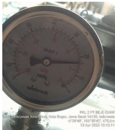
Gambar 19 : pressure gauge sebagai indikasi uji kebocoran (Sumber : Dokumentasi pribadi di PT BEJE)
