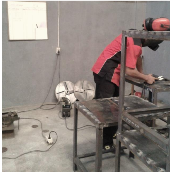
Gambar 12 : Pengecekan proses pereakitan rangka (Sumber : Dokumentasi PT BEJE)
