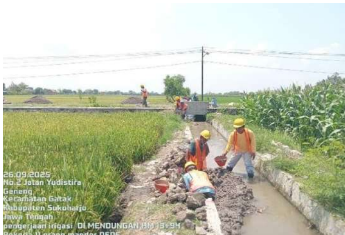
Gambar 4.5. Perbaikan Jaringan Irigasi Tersier
