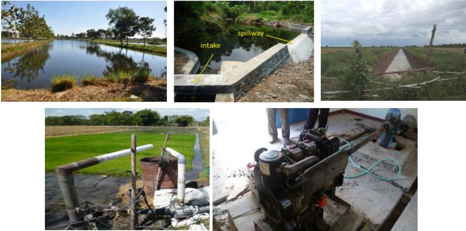
*Gambar 2. Sumber air irigasi suplementer embung, dam parit, long storage (atas: berturut-turut dari kiri ke kanan) dan pompa pada sumur air tanah dangkal dan air tanah dalam (bawah: kiri dan kanan)*
