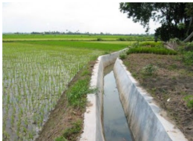
Gambar 2. Saluran Irigasi Sekunder
