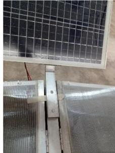
Gambar 4. 16. Pemasangan Panel Surya
