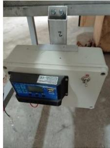
Gambar 4. 17. Pemasangan *Solar Controller*
