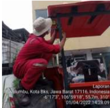
Gambar 4.5 Kegiatan pemasangan cover lampu traktor
