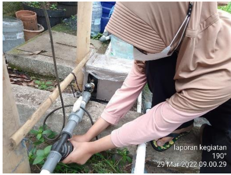
11. Pembersihan filter air pada sistem.
