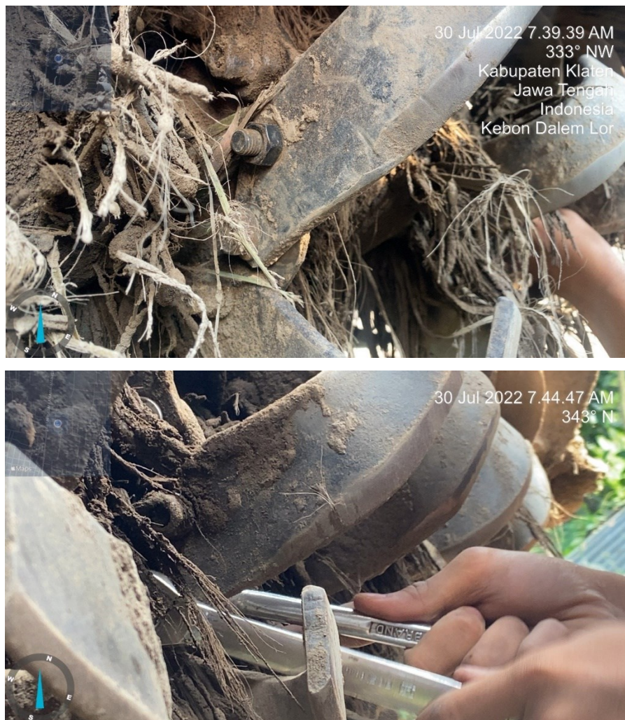
Gambar 4. 18. Proses pembersihan dan pengencangan baut rotary
