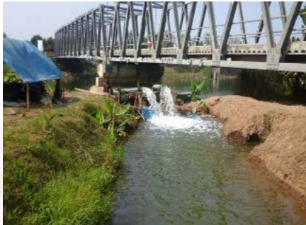
Saluran Sekunder Pusakanegara untuk Sawah Indramayu 11.000 Ha.
