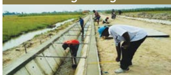
Rehabilitasi Jaringan Irigasi
