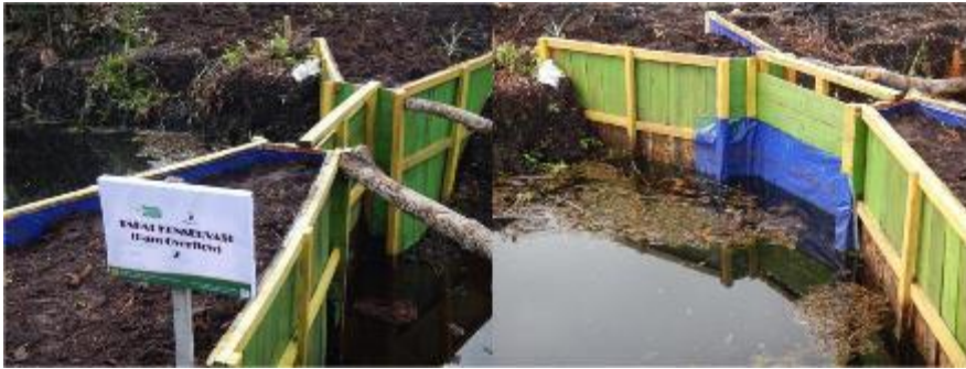
Gambar 12. Tabat yang dibuat secara sederhana, dapat berfungsi sebagai tabat konservasi (foto: Dariah)
