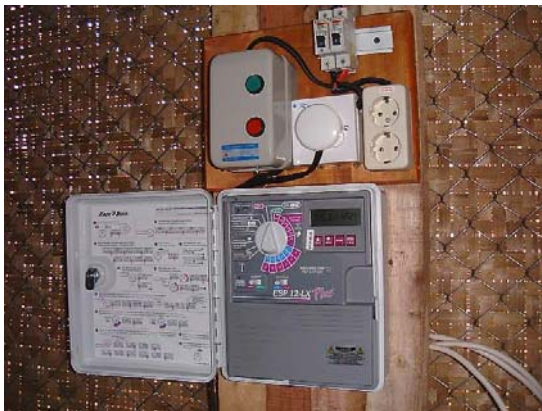
Gambar 21. Alat untuk mengatur distribusi larutan nutrisi dalam sistem fertigasi tetes di Balai Penelitian Tanaman Sayuran, di Lembang (Foto: N. Gunadi)
