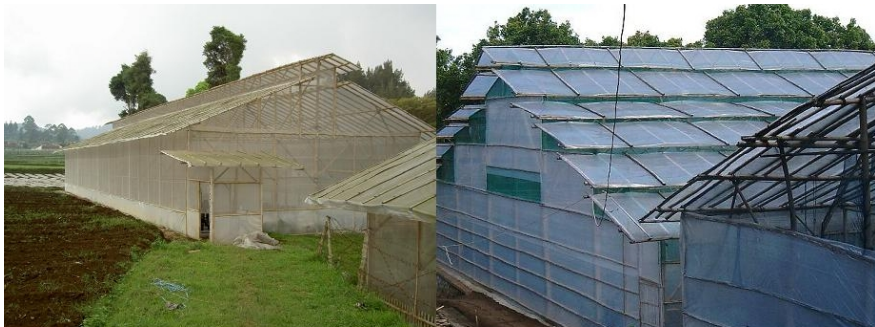
Gambar 6. Dua contoh rumah plastik konvensional yang terbuat dari bambu yang umum digunakan oleh petani paprika di Indonesia (Foto: de Putter)
