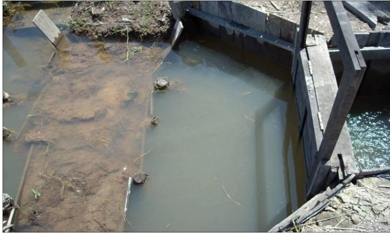
Gambar 4. Pintu air dengan sistem tabat ( dam overflow ) yang dapat membuka dan menutup secara otomatis mengikuti pasang surut air
