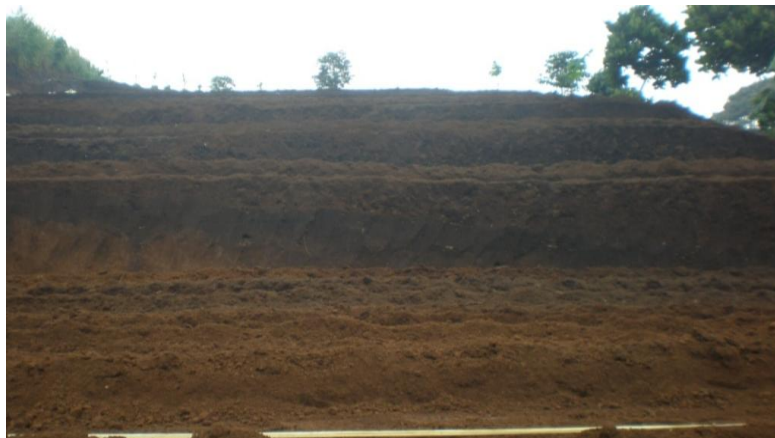
Gambar 4. Teras bangku pada model C dengan kemiringan lahan 22% di Hulu Sub DAS Cikapundung
