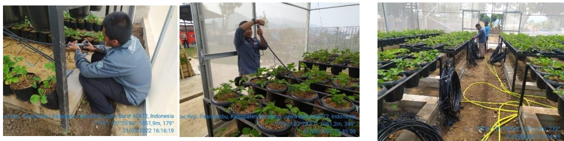
Gambar 7. Pemasangan instalasi di bagian dalam greenhouse
