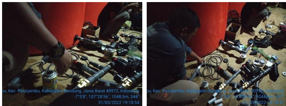
Gambar 5. Pemasangan instalasi di bagian luar greenhouse
