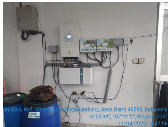
Gambar 13. Pengecekan dan Perbaikan Panel Kontrol
