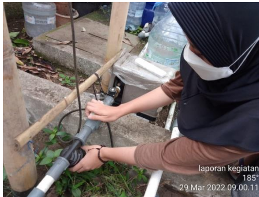
Gambar 10. Pengecekan dan Pembersihan Filter
