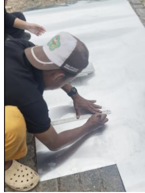
Pemotongan lembaran pelat seng sesuai pola dan ukuran yang telah ditentukan.
