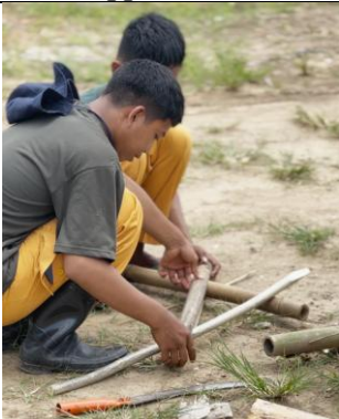
Penyiapan bambu/kayu untuk pembuatan tiang penyangga perangkat
