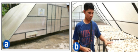
Gambar 3. a) Rumah jemur (Solar Dryer) b) Penjemuran biji dalam rumah jemur
