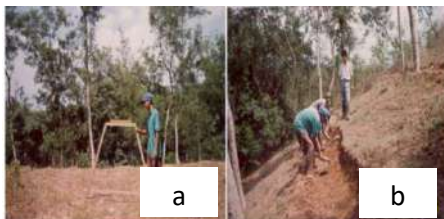
Gambar 2. Pembuatan teras bangku/sabuk gunung pada lahan miring. Alat bantu pembuatan garis kontur dengan segitiga sama kaki dengan bandul atau trapesium dengan waterpass (Gb.2a) dan pencangkulan tanah untuk meratakan teras (Gb.2b)
