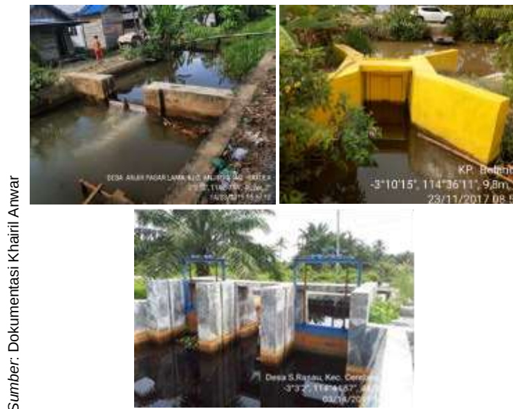
Gambar 4. Contoh model pintu tabat/dam bertingkat (tabat limpas) pada tipe luapan C, pintu sistak pada lahan tipe luapan B, dan pintu ulir untuk lahan tipe luapan A.
