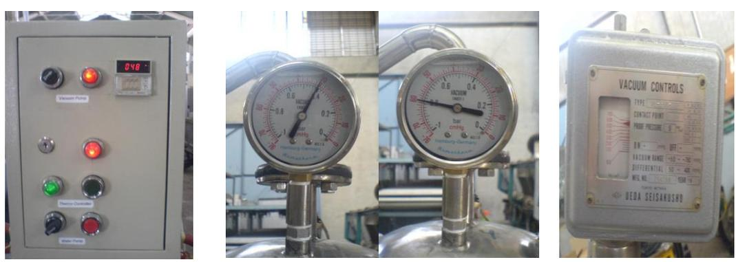
Gambar d. Box kontrol panel, vacuum gauge, dan kontrol tekanan vakum
