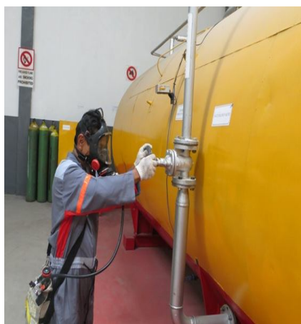
Gambar 13 Pembukaan katup udara segar
