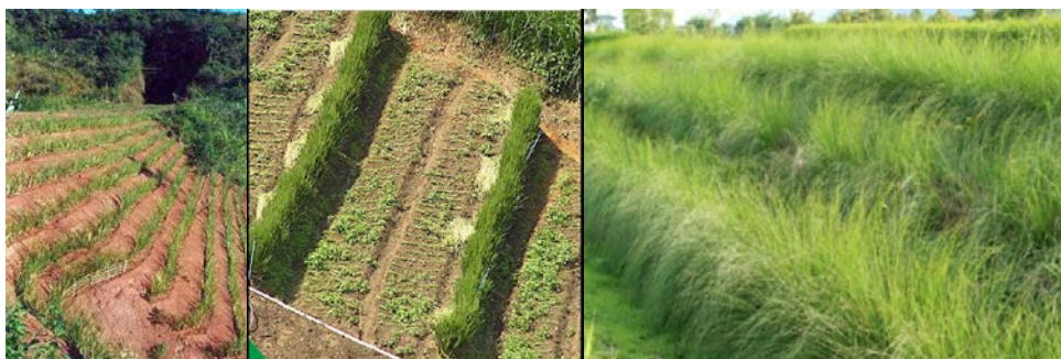
Gambar 10. Contoh penanggulangan longsor secara vegetatif dengan menggunakan vetiver
