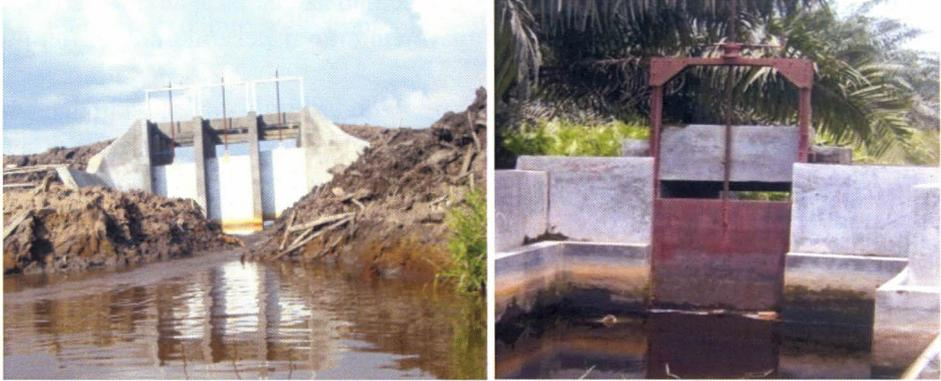
**Gambar 14.** Model pintu air pada saluran sekunder (kiri) dan saluran tersier (kanan) (Dok. M. Noor/Balittra)
