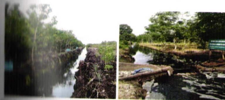
Gambar 5. Saluran drainase pada lahan gambut (kiri) dan pintu air pengontrol kedalaman muka air di saluran drainase (kanan) (Foto: Maswar)
