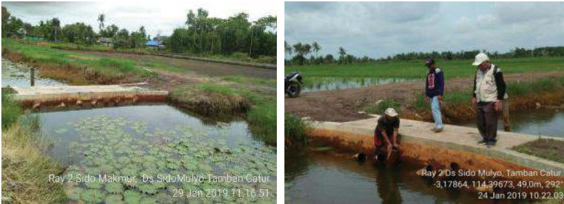
Gambar 5.6 Model tabat dengan sistem elbow (TASEL). Air masuk apabila tinggi dan tertahan di saluran. Air dapat diturunkan dengan menurunkan elbow
