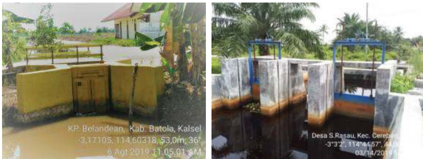
Gambar 5.5 Model pintu air (pintu ulir) untuk lahan rawa pasang surut tipe luapan A (kiri) dan pintu semi-otomatis untuk tipe luapan A atau B (kanan)
