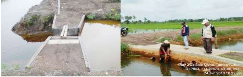
Gambar 70. Sistem Tabat untuk Mempertahankan Permukaan Air Tanah Sesuai Kebutuhan Air bagi Tanaman Budi Daya
