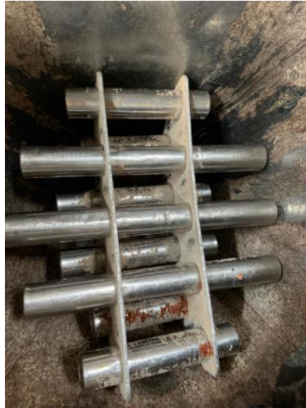
Gambar 8. Pemeriksaan magnet pada hopper
