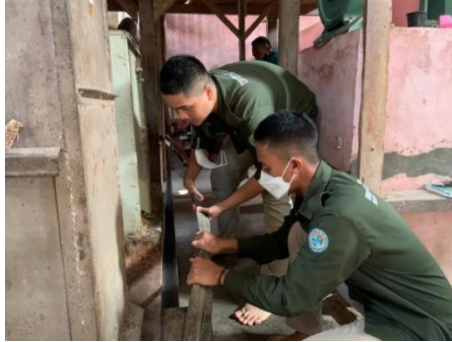
Pemasaangan v-belt untuk penggerak elevator pada Rice Milling Unit (RMU)
