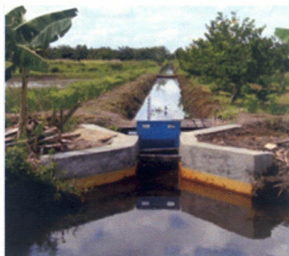
Gambar 6. Skema sistem tata air satu arah dan model pintu air ( flapgate )
