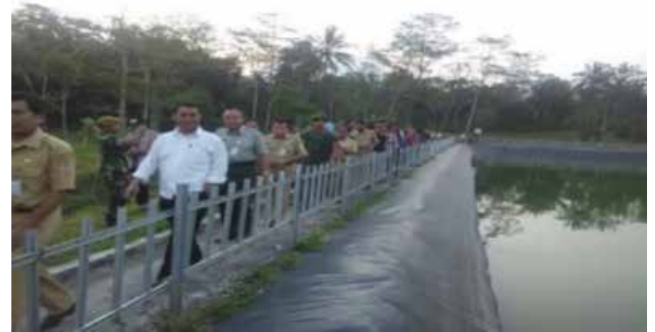
Gambar 23. Embung dengan pelapis geomembran di (a) Desa Girioto, Kec. Ngemplak Kab. Boyolali dan (b) Lokasi PENAS XV, Banda Aceh.
