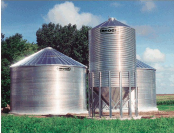
Gambar 82. Silo untuk penyimpanan biji-bijian kering.
