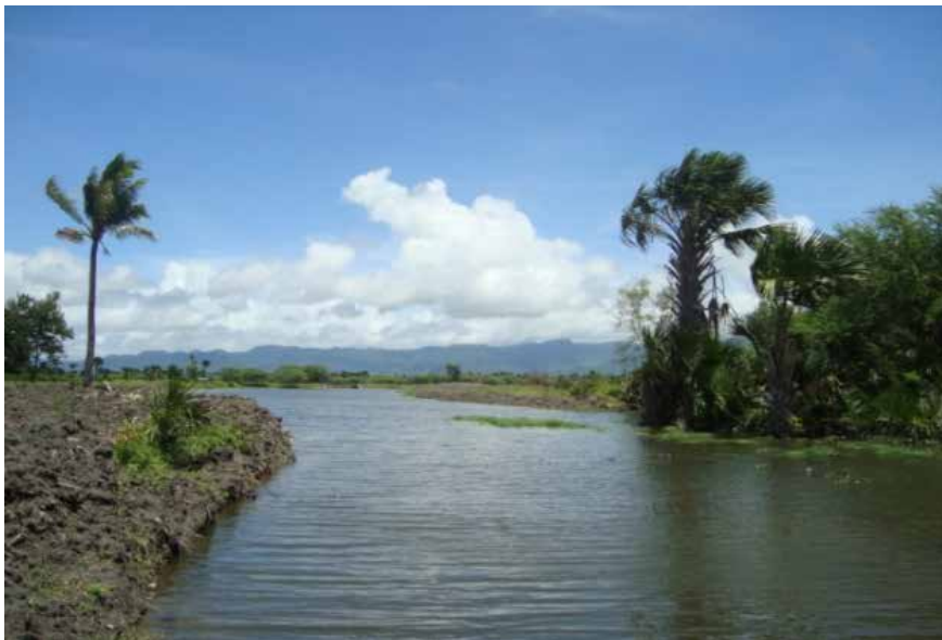
Gambar 22. Embung konstruksi pasangan batu di Gunung Sugih, Lampung Tengah (a) dan embung lapisan tanah di Naibonat, Kupang.
