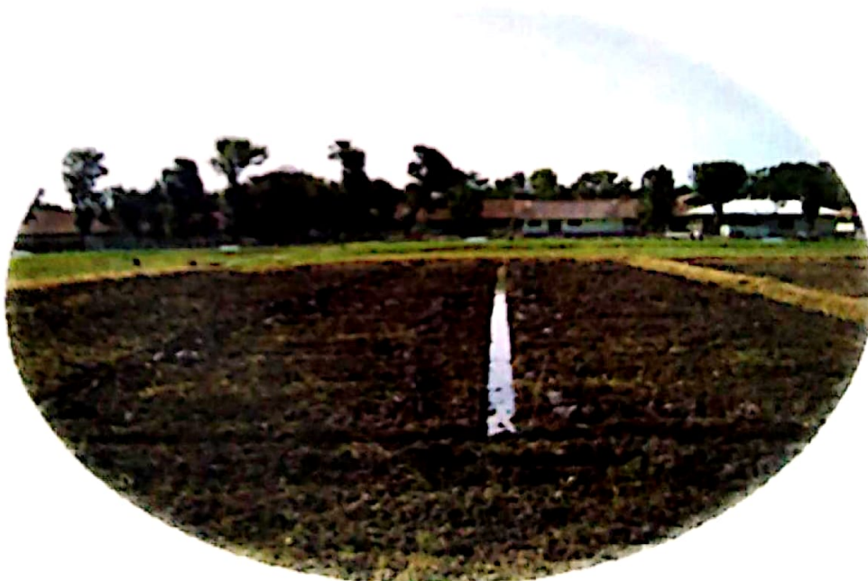
Gambar 1. Pembuatan saluran drainase.
