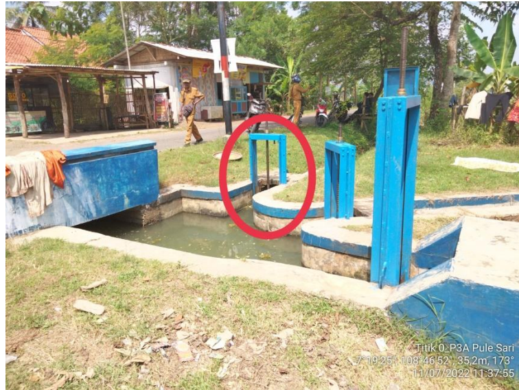
Gambar 9. Pintu Bagi Sumber Sari 1
