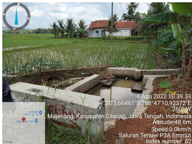
Gambar 12. Saluran Irigasi Tersier 2
