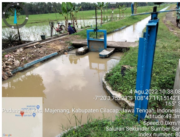
Gambar 10. Pintu Bagi Sumber Sari 2
