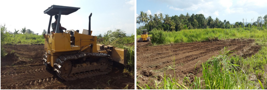
Gambar 1. Pembersihan lahan di lokasi TP Banyumulek
