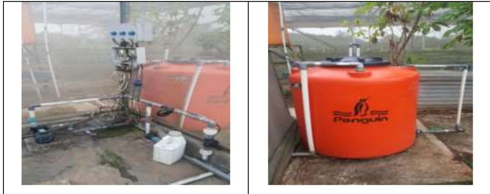
Gambar 10 Sistem fertigasi pada irigasi tetes
