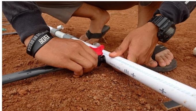
Gambar 63. Pemasangan offtake
