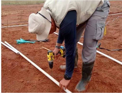
Gambar 61. Proses melubangi pipa
