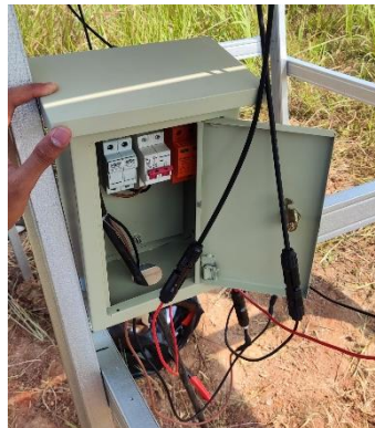
Gambar 52. Susunan komponen pada box panel
