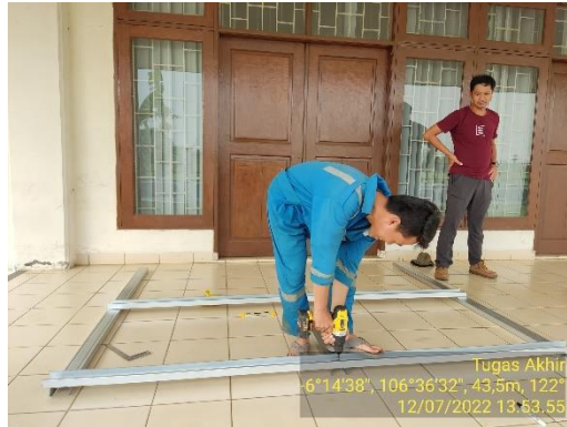
Gambar 49. Pembentukan dudukan solar panel
