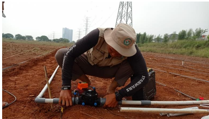
Gambar 64. Pemasangan solenoid valve
