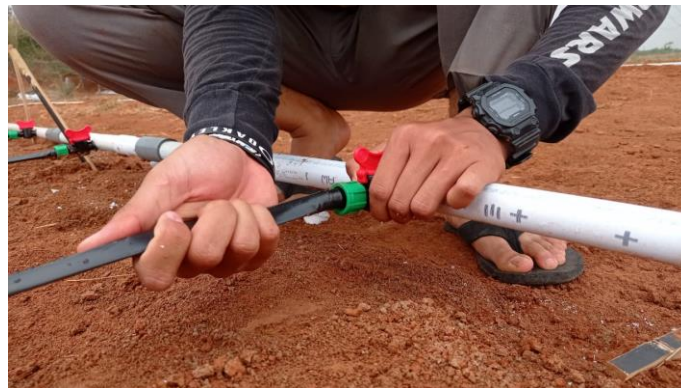
Gambar 66. Pemasangan selang drip ke bagian offtake
