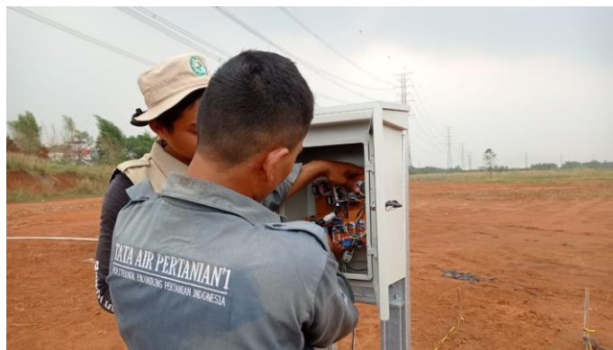
Gambar 71. pemasangan mikrokontroler
