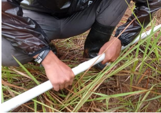
Gambar 59. Penyambungan pipa
