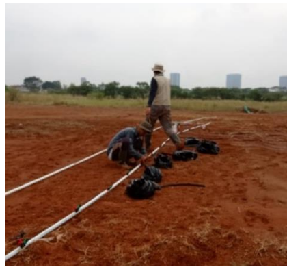
Gambar 65. Pemasangan selang drip
