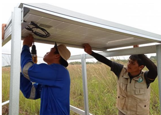
Gambar 51. Pemasangan solar panel
