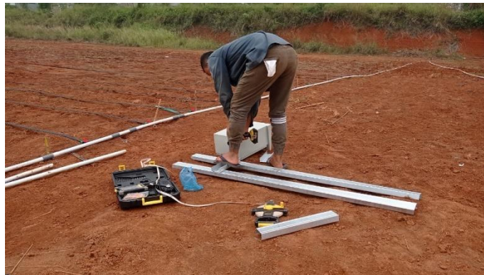
Gambar 70. Pemasangan box panel
