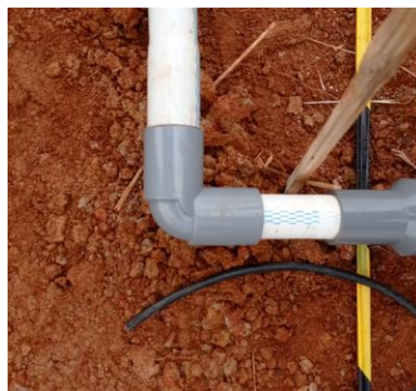
Gambar 60. Sambungan pipa utama dengan lateral
