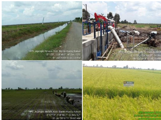
Gambar 3. Bangunan tanggul, saluran, dan pompa serta pertumbuhan tanaman padi di areal gelar teknologi HPS di desa Jejangkit Muara, KAB. Barito Kuala, Kalimantan Selatan.
