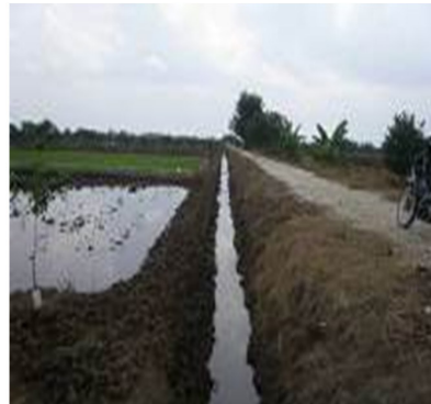
Gambar 12. Model penataan saluran tata air mikro (tam) di lahan rawa pasang surut (Sumber: Dokumentasi Balittra 2012)
