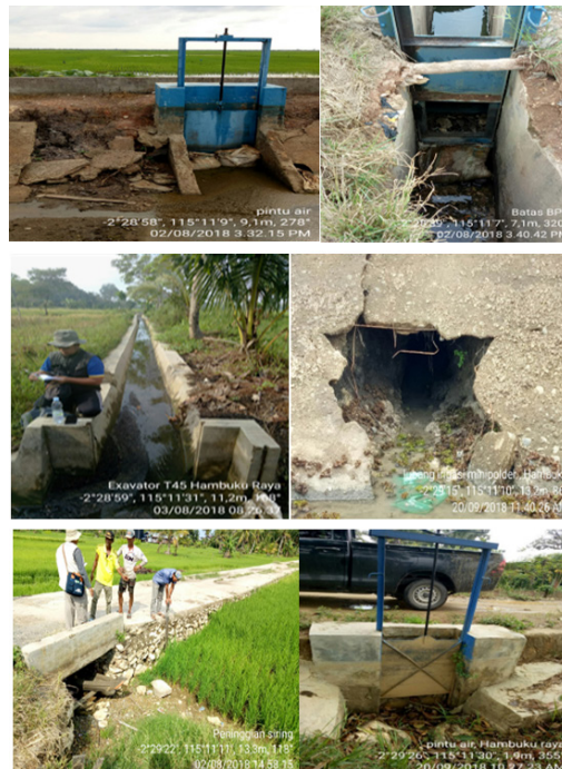
Gambar 10. Keragaan infrastruktur Mini-polder Hambuku 2018. (1) Dan (2) pintu penghubung saluran irigasi polder dengan Mini-polder; (3) Saluran irigasi Sungai Nagara ke area mini-polder; (4) Jalan inspeksi irigasi yang berfungsi sebagai tanggul penahan air saluran irigasi polder dengan area mini-polder, dibobol petani; (5) Jembatan penghubung yang belum memiliki pintu pengendali air; dan (6) Pintu penahan luapan Sungai Nagara.
