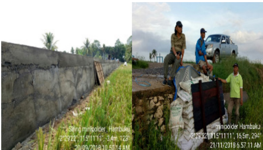
Penutupan Lubang dengan Karung Pasir
