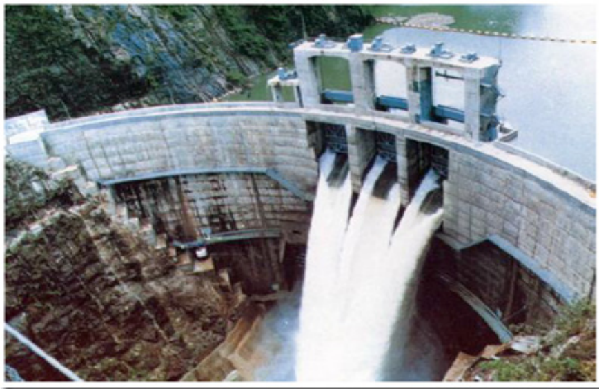
Gambar 15. Bendungan atau dam
