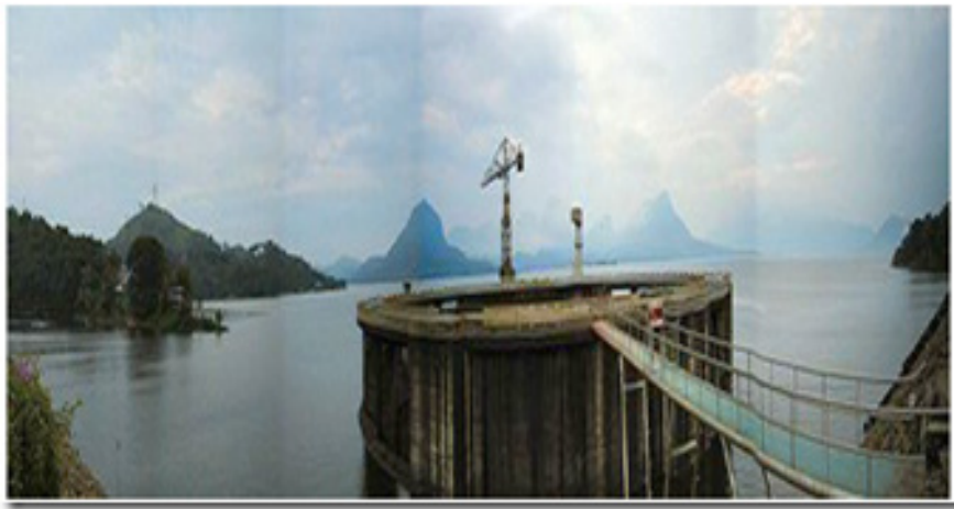
Gambar 22. Bendungan Sebagai Pembangkit Listrik
