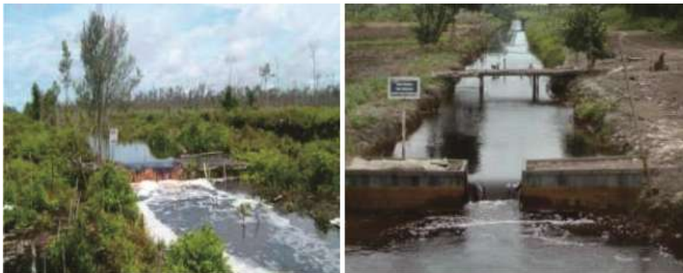
Gambar 10. Pintu tabat dalam pengelolaan air di lahan gambut (Lamunti, Kalteng)
