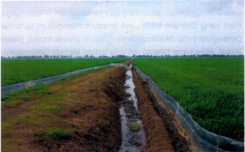
Gambar 3. Pemasangan TBS Full Protection pada hamparan persawahan.
