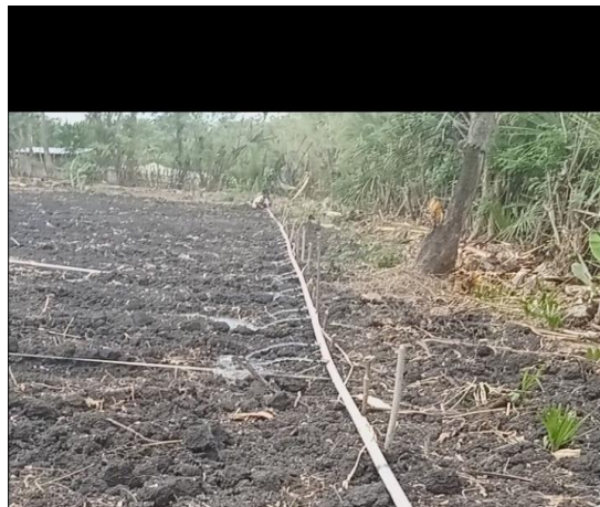
Gambar 4. Kondisi pipa dalam kondisi jadi
