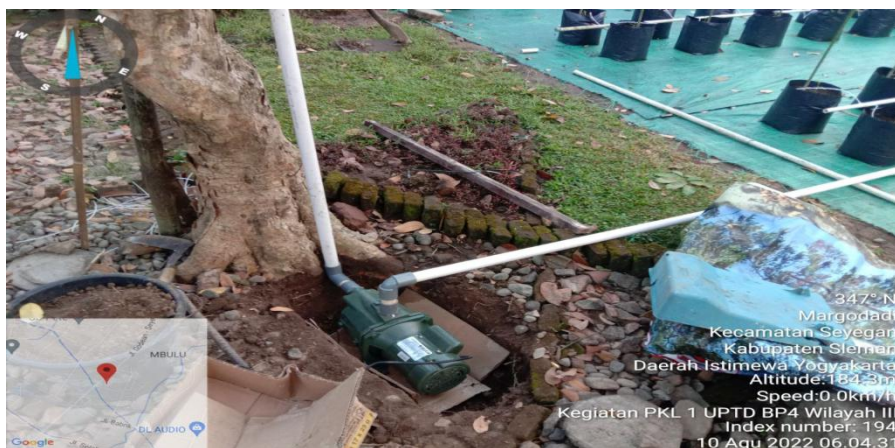
Gambar 13. Menyiapkan pompa aliran air
