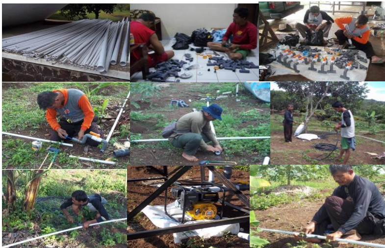
Gambar 26. Penyiapan komponen dan pemasangan jaringan irigasi lahan tanaman manggis seluas 1 Ha.
