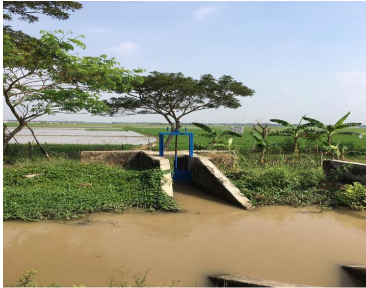
Gambar 4. Pintu Air Saluran Sekunder B
