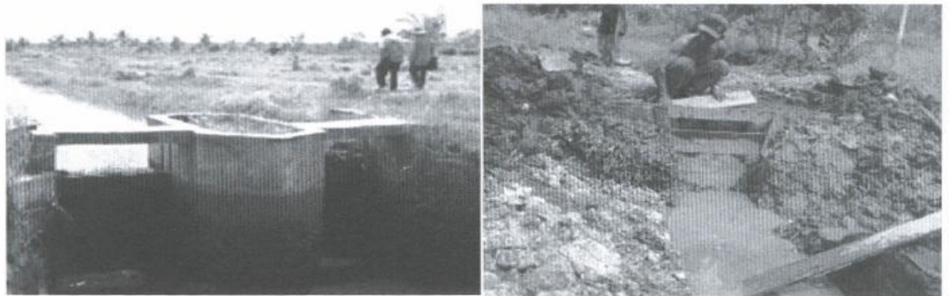
Gambar 42. Model pintu tabat pada lahan tipe C dan D: tabat dari beton dan dari kayu (ulin)
