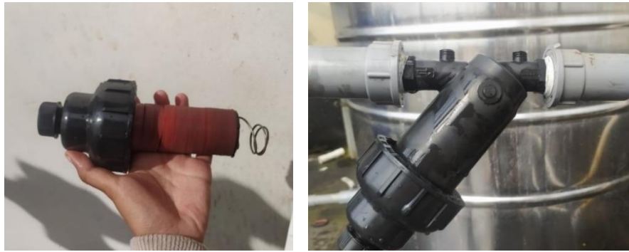
Gambar 4.4 Pembersihan Pada Discfilter .
