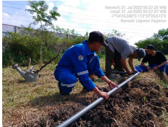
Gambar 7. Pemasangan pipa parapon
