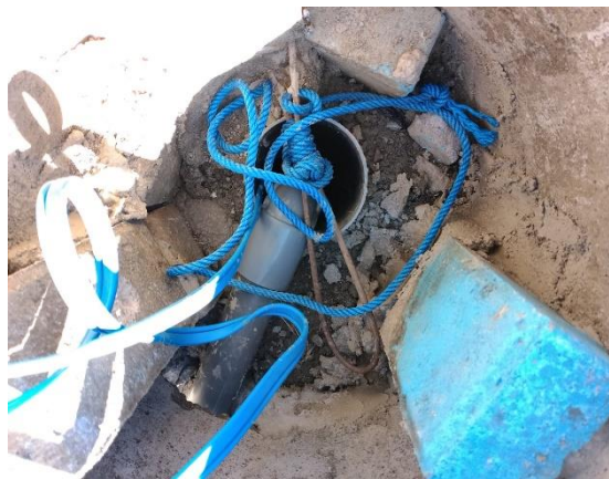
Gambar 6. Pengikatan pompa dengan tali
