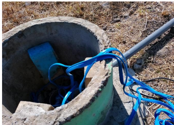
Gambar 8. Pompa dimasukkan ke dalam sumur
