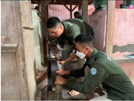
Proses pemasangan v-belt untuk menggerakkan bucket elevator
