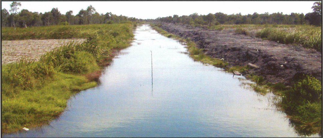
Saluran drainase utama dan cabang (tengah) dan saluran drainase cabang (bawah).
