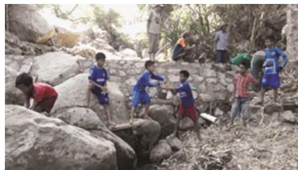
Pembuatan dam parit di Desa Mbawa, Kecamatan Donggo, Kabupaten Bima, Nusa Tenggara Barat secara swadaya dan bergotong royong.
