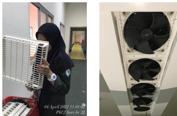
Gambar 15. Koil evaporator (kiri) blower evaporator (kanan)
