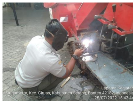
Gambar 4.3. proses penambalan tangki hidrolik yang bocor
