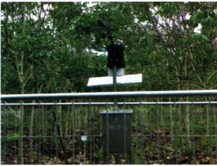
Gambar 4. AWS dengan pagar besi di demplot ICCTF di Kalimantan Tengah.
