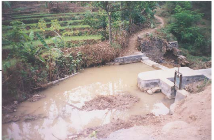
Gambar 13. Dam pengendali dari beton
