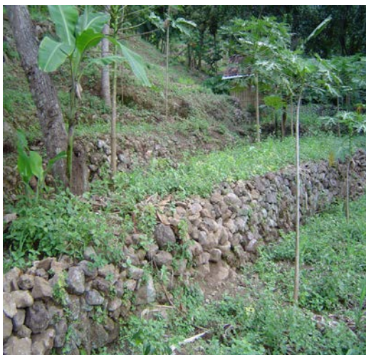
Gambar 12. Trap-trap terasering dari batu
