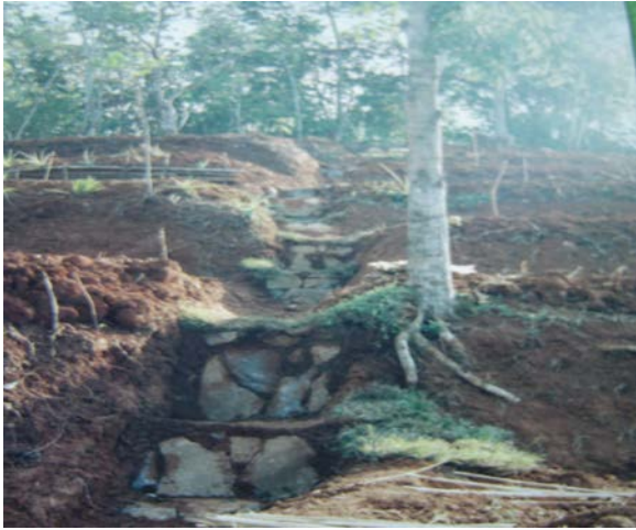
Gambar 6. Saluran pembuangan air (SPA) dengan BTA dari batu
