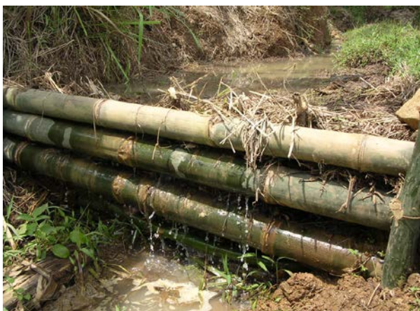
Gambar 7. Bangunan terjunan air dari bambu
